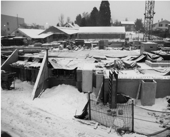
■ Dezember 2010 – Wintereinbruch und Einstellung Bauarbeiten
