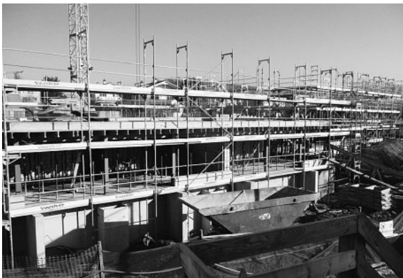
■ ab 7. Januar 2011 – dank gutem Bauwetter verlaufen die Arbeiten wieder nach Plan
