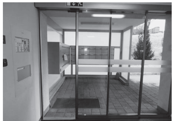
Neuer Eingangsbereich mit automatischer Schiebetüre. Oben: die Zentrale der Brandmeldeanlage.
