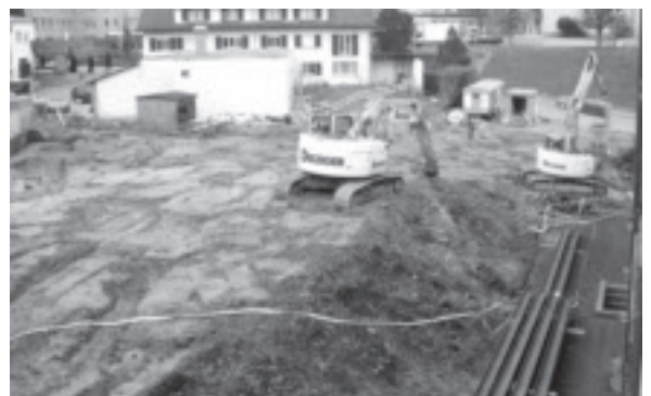
Baugrube Tiefgarage
