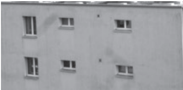
verschmutzte Fassade
