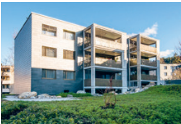
Haus Rappenstein 49 mit Naturschiefer-Fassade, neuen Fenstern und Balkonen
