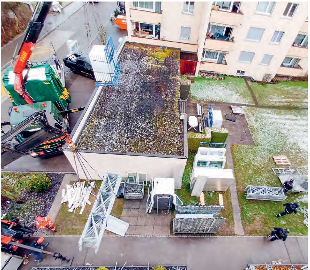
BAWO-HINTERBERG Beginn Sanierung
