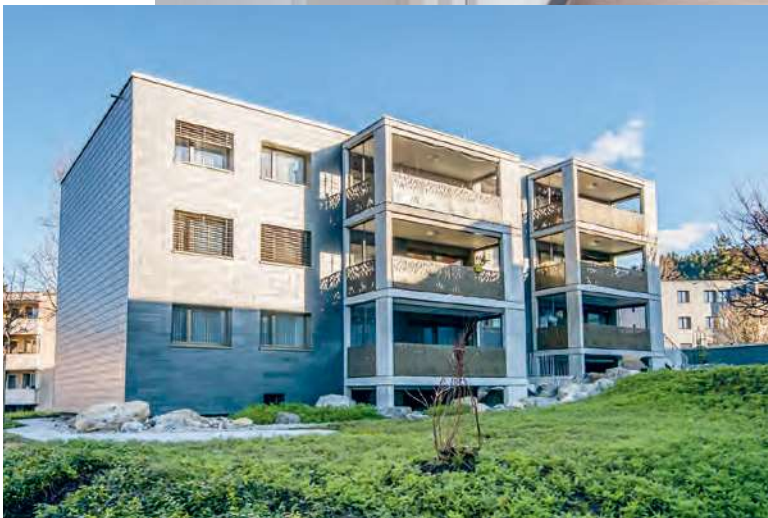
MFH RAPPENSTEIN Nach erfolgter Renovation.
