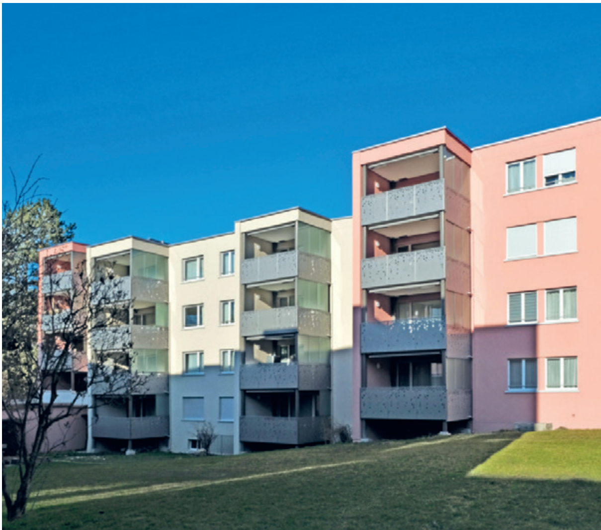
HINTERBERG Aussenansicht vor und nach der Sanierung.
