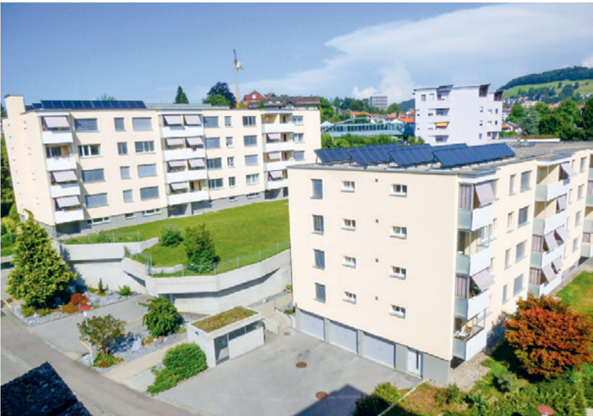
MFH ZWYSSIGSTRASSE 21-25 Bestehende Balkone
