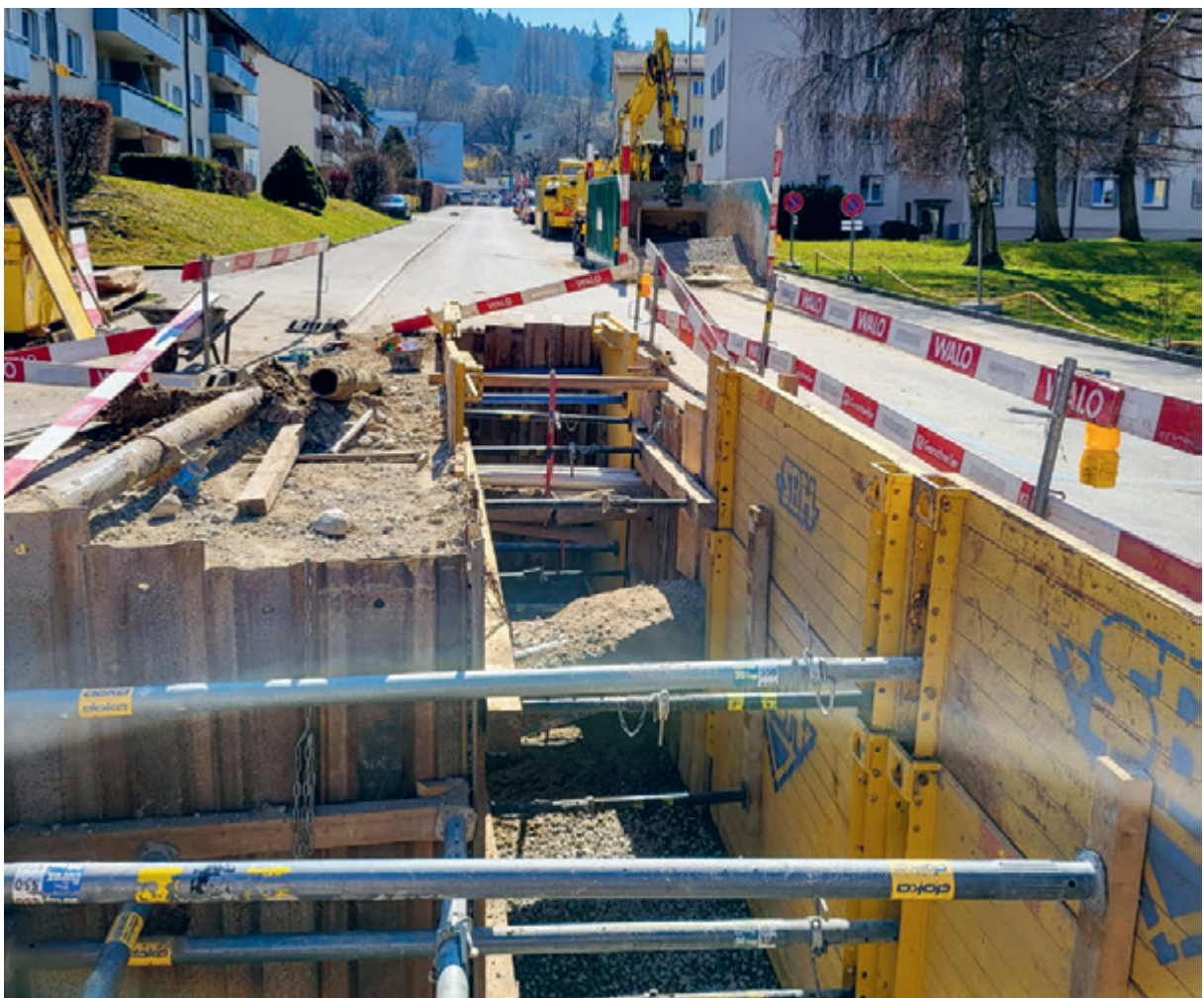
FUCHSENHALDE Erschliessung Fuchsenstrasse mit Fernwärme, März 2022.
