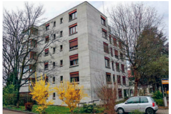
GLASERSTRASSE 3A, 9000 ST. GALLEN 10 Wohnungen
