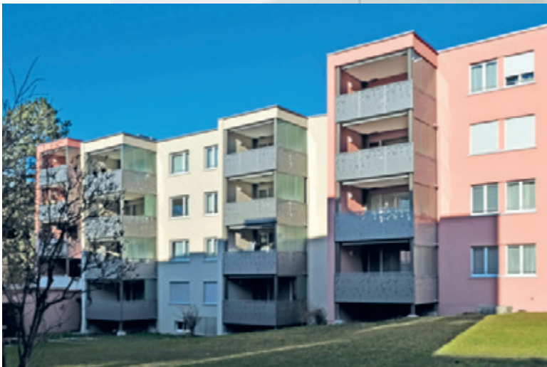
MFH HINTERBERG Nach erfolgter Sanierung.
